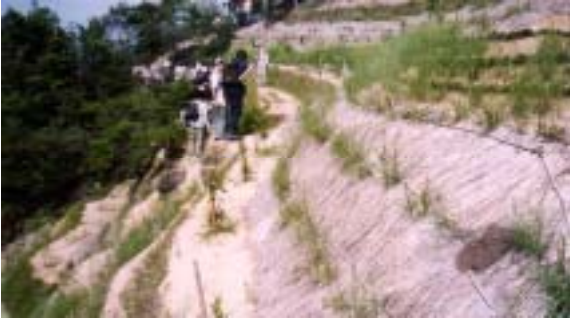
図-10 ワラを斜面表面に引き詰めて浸食を防止する手法(ワラ伏せ工)
