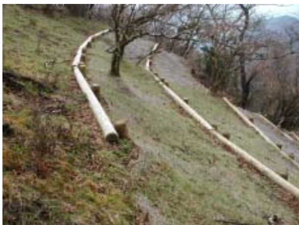
丸太柵工 + むしろ伏工
