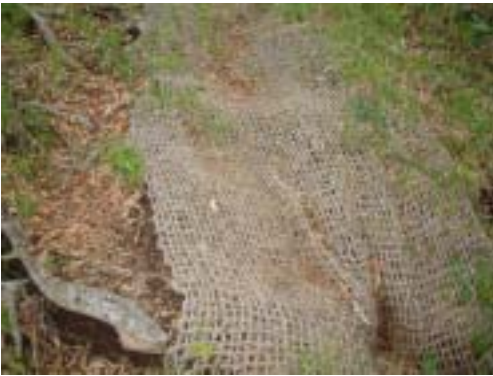
図-11 ジュートネットによる被覆により浸食を防止する手法(丹沢)
