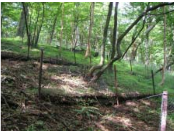
亀甲金網筋工
