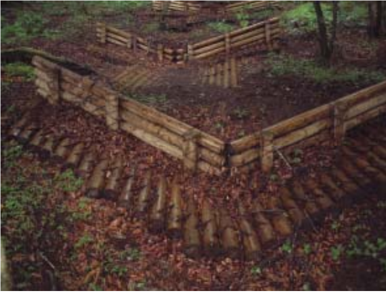
図-14 丸太柵工によるガリ部の浸食軽減工(丹沢堂平)
