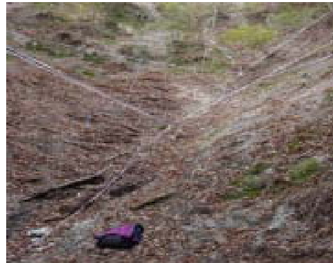
写真-6 崩壊域下部 (調査地1)
