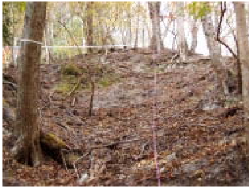
写真-5 崩壊源頭部 (調査地1)
